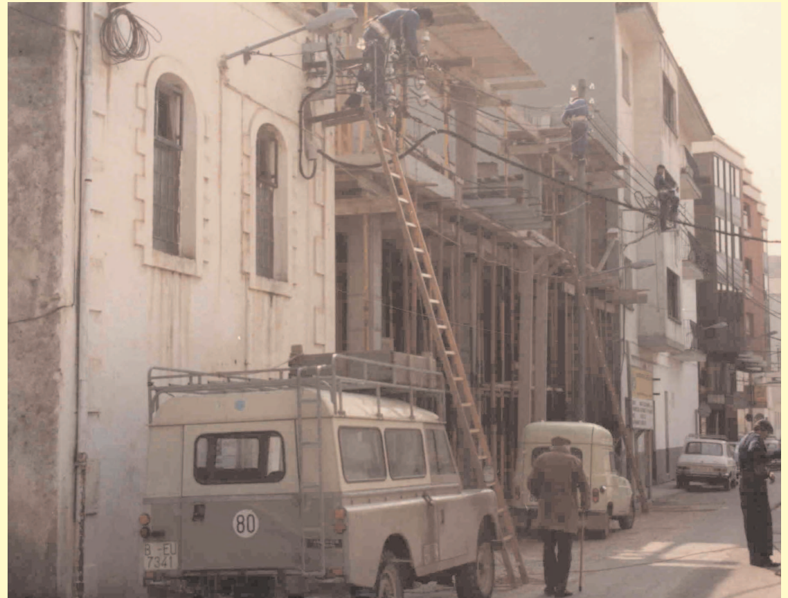
1985. Construcció del Centre Cultural del carrer Orient 1985
