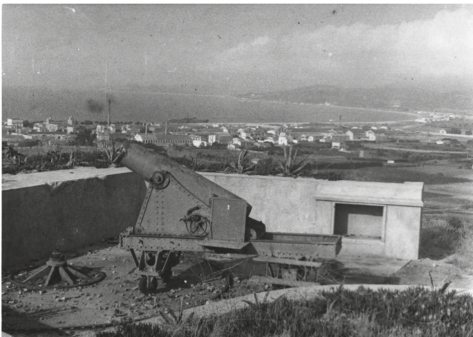
Bateria de costa del puig del Molí de Vent, [1939-1940]. Autor desconegut. Col. Imatges Ajuntament. Servei d'Arxiu Municipal de Palamós
