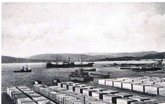
Imatge que mostra la utilització de grans barcasses pel transport dels blocs més pesats.
