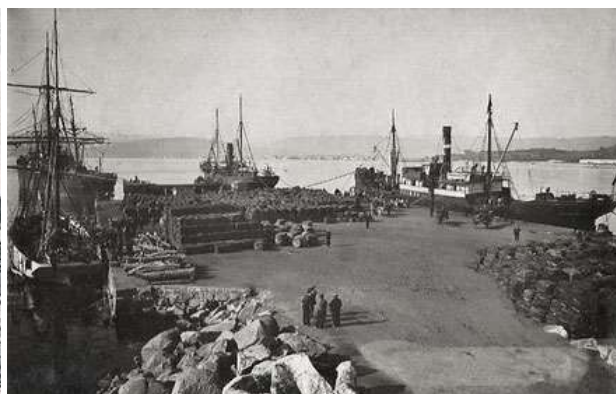
Fotografia de la construcció del moll Nou del port de Palamós.
